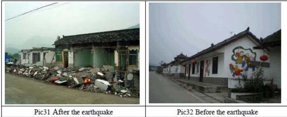
Image 31 : après le séisme Image 32 : avant le séisme
