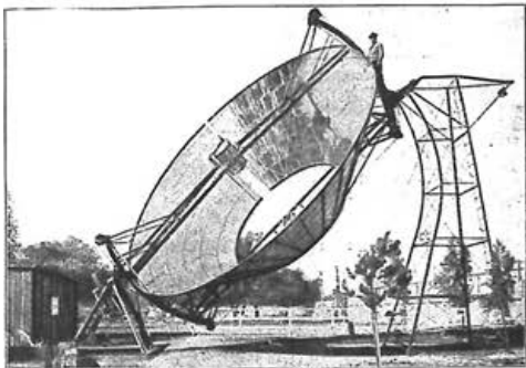
Sunčani motor, jedan od najčudesnijih aparata na svijetu; njime se na jednoj plantaži u Kaliforniji hvata sunčana toplina, koja ukapljuje vodu, a pri tom dobivena para tjera stroji, koji može u jednoj minuti naprasti 80 hektolitara vode, koja se rabi za natapanje tla.
