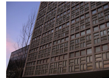
Le bâtiment de 1955
